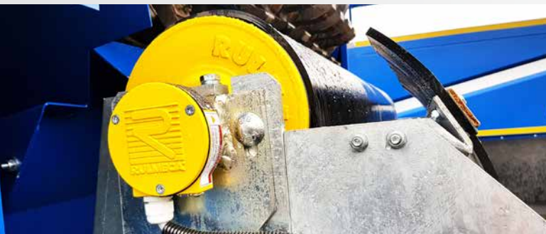
Elektrinė išmetimo transporterio pavara
